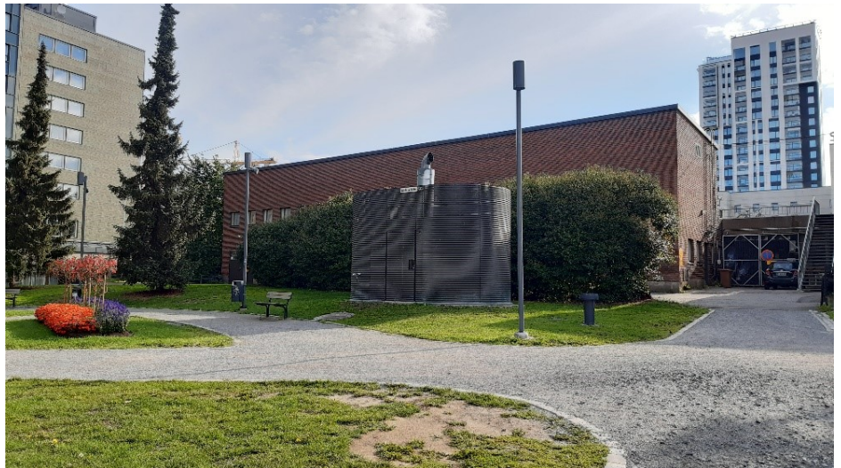
Näkymä Posteljoonipuistosta. Kuvan keskialalla P-Hämpin ajotunneliin (Tullin ramppiin) liittyvän pystykuilun maanpäällinen rakenne ja oikealla reunassa reunalaiturille johtava porras. (kuva: Tampereen kaupunki 2022)
