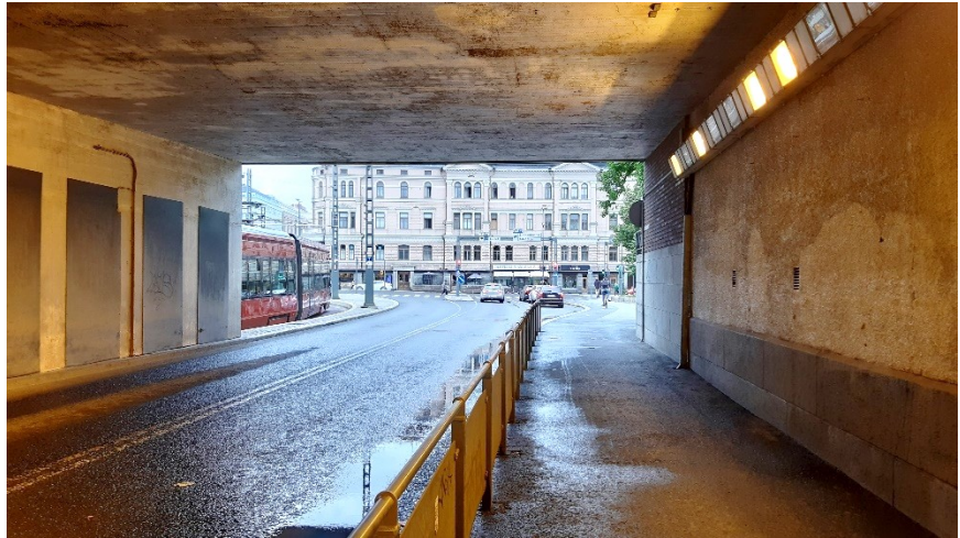
Näkymä Itsenäisyydenkadun tunneliaukolta kohti Rautatienkatua. (kuva: Tampereen kaupunki 2022)
