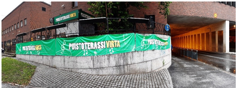
Terassialueen kaareva reunamuuri. (kuva: Tampereen kaupunki 2022)
