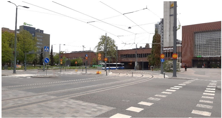
Näkymä Rautatienkadun ja Hämeenkadun risteyksestä kohti Itsenäisyydenkadun tunnelia ja Posteljoonipuistoa. (kuva: Tampereen kaupunki 2021)
